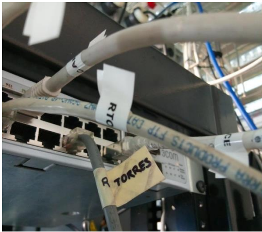
Fig. 2. Ejemplo de etiquetado de los cables pertenecientes a cada equipo en el punto de conexión a puertos de internet y tomacorrientes.
